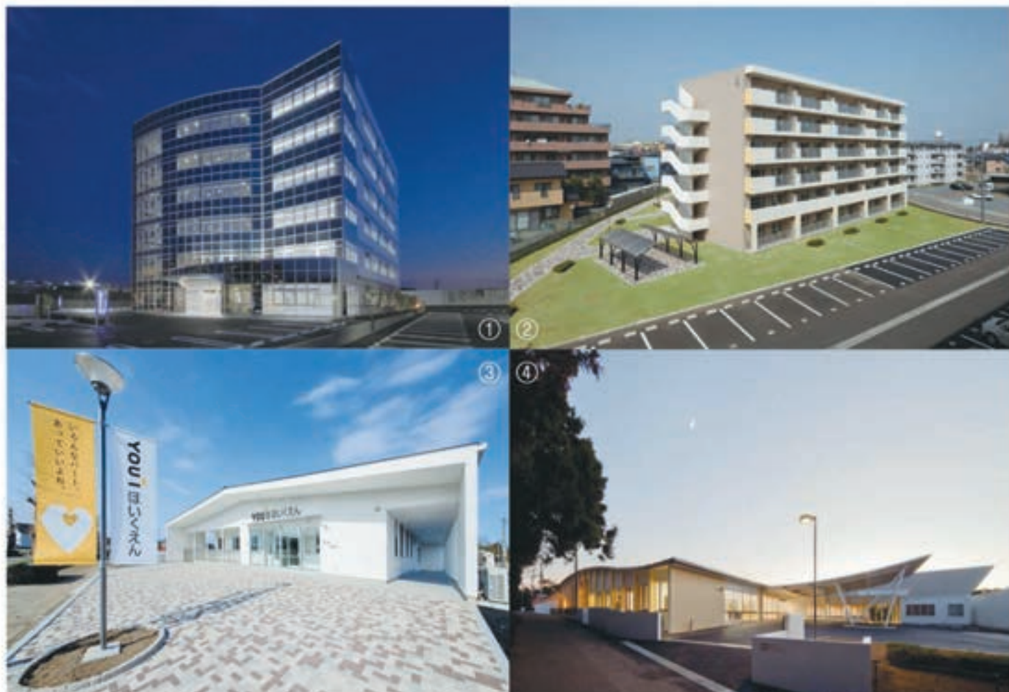
施工事例 ①つくば駅前テナントビル、②茨城県営アパート、③私立保育園、④特別養護老人ホーム
