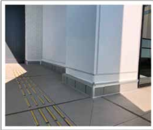
防水立上乾式パネル工事 (HMプロテクターシステム)
